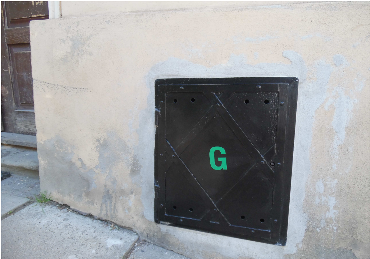
Schodowa 3 – wykonanie wraz z montażem drzwiczek do wnęki na zawór główny gazowy.
