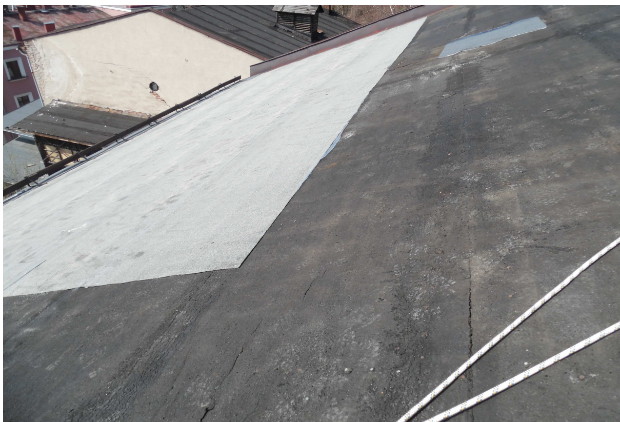
Śrutarska 39 – wykonanie pokrycia dachowego z papy termozgrzewalnej.
