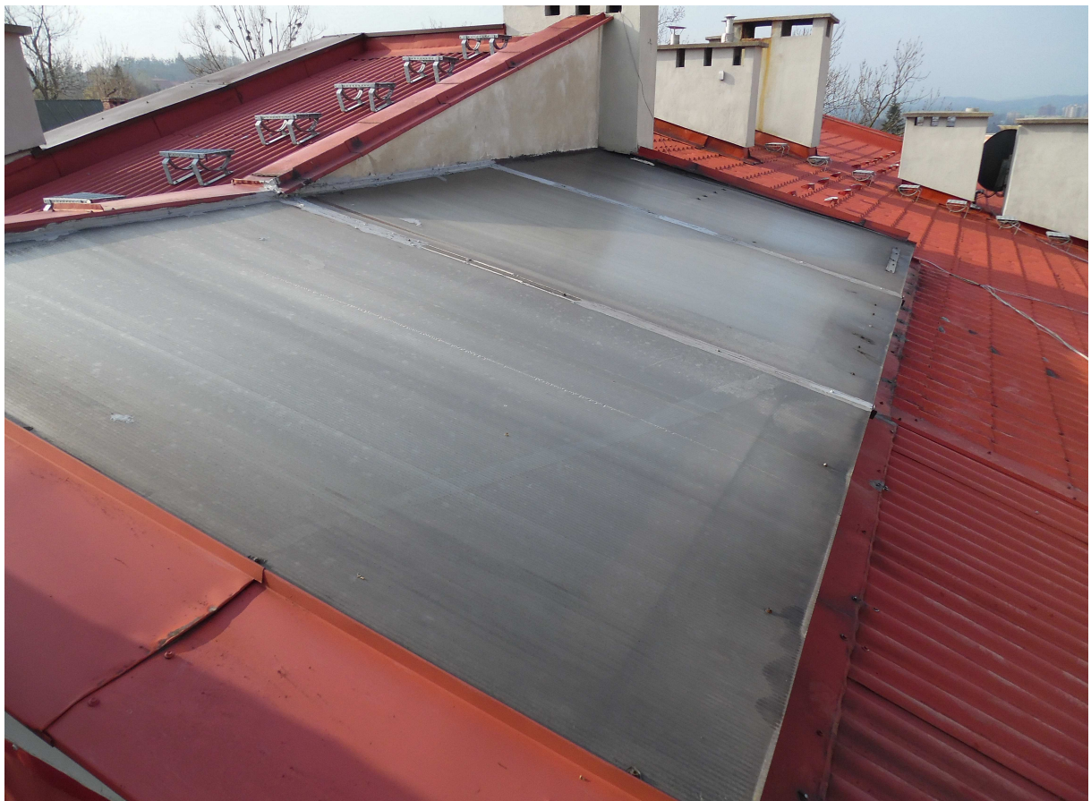
Srebrna 1 – wymiana naświetla z płyt poliwęglanowych. Poniżej, stan pokrycia przed wymianą.
