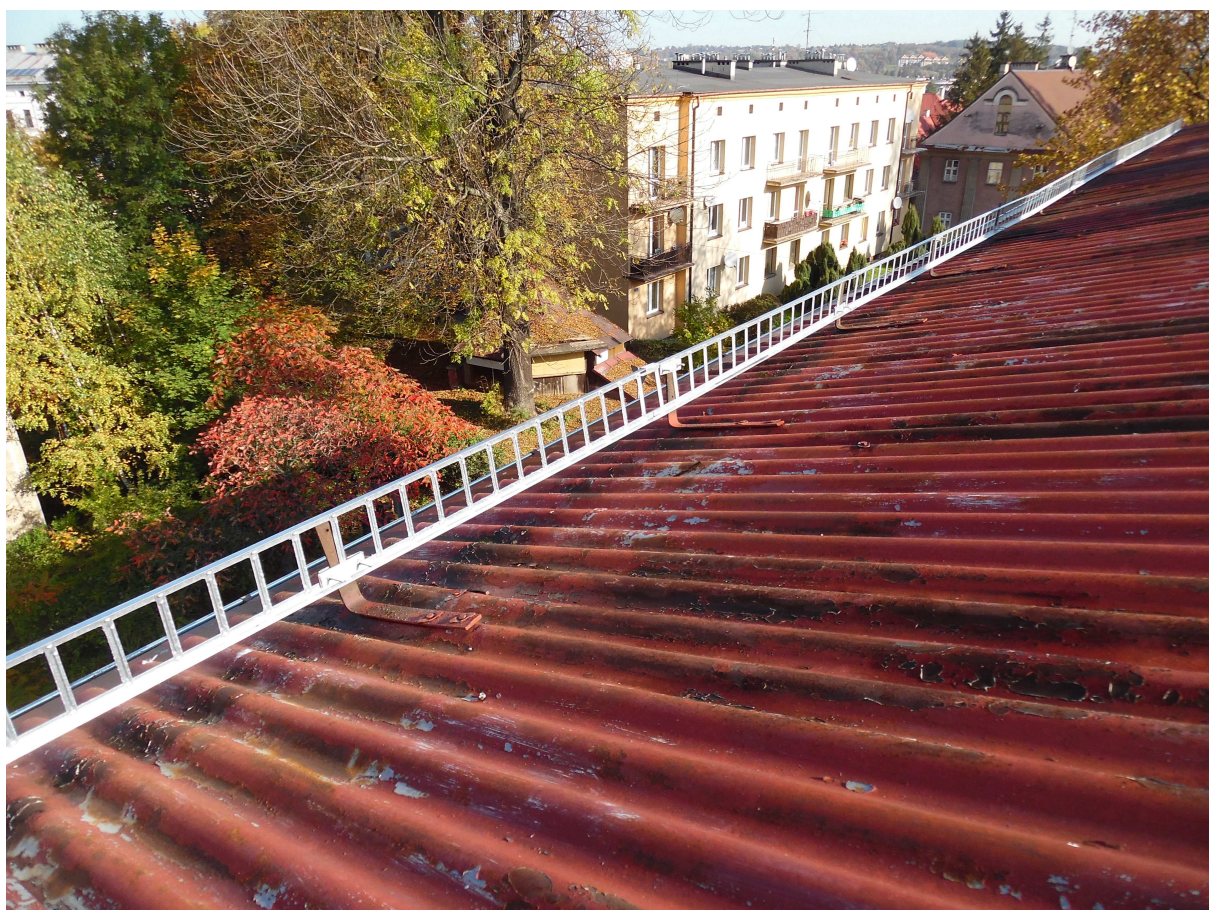
Bielska 2 – wymiana rynien dachowych oraz płotków śniegowych.
