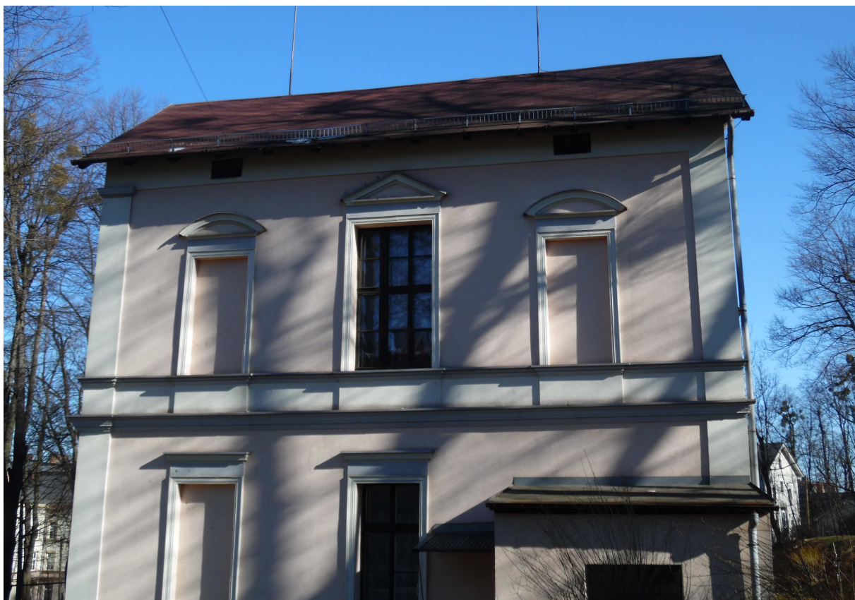
Sikorskiego 1C – usuwanie szkód po przewróconym drzewie na budynek.
