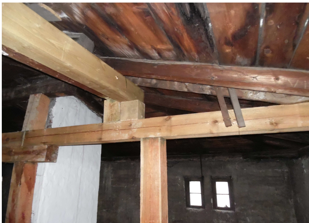
Bielska 2 – wzmocnienie konstrukcji więźby dachowej.
