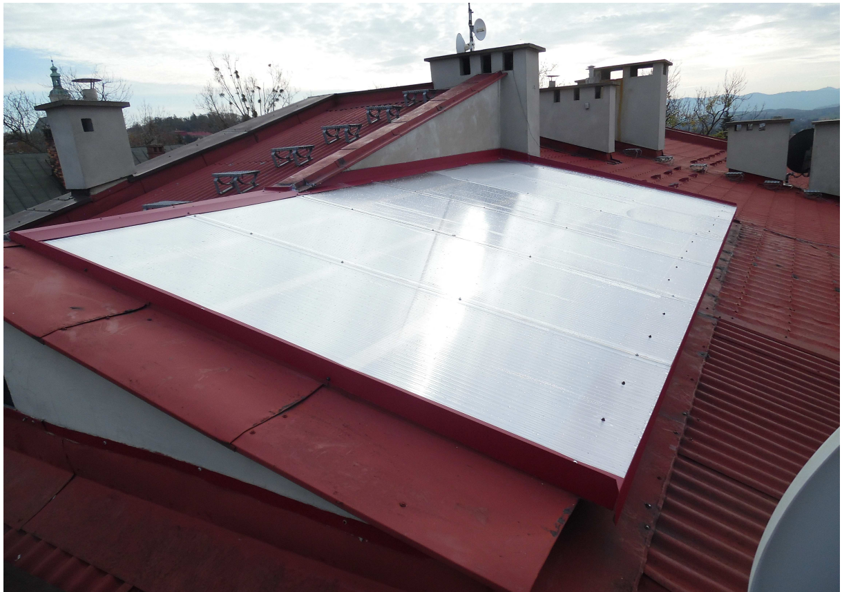
Srebrna 1 – wymiana naświetla z płyt poliwęglanowych. Poniżej, stan pokrycia przed wymianą.
