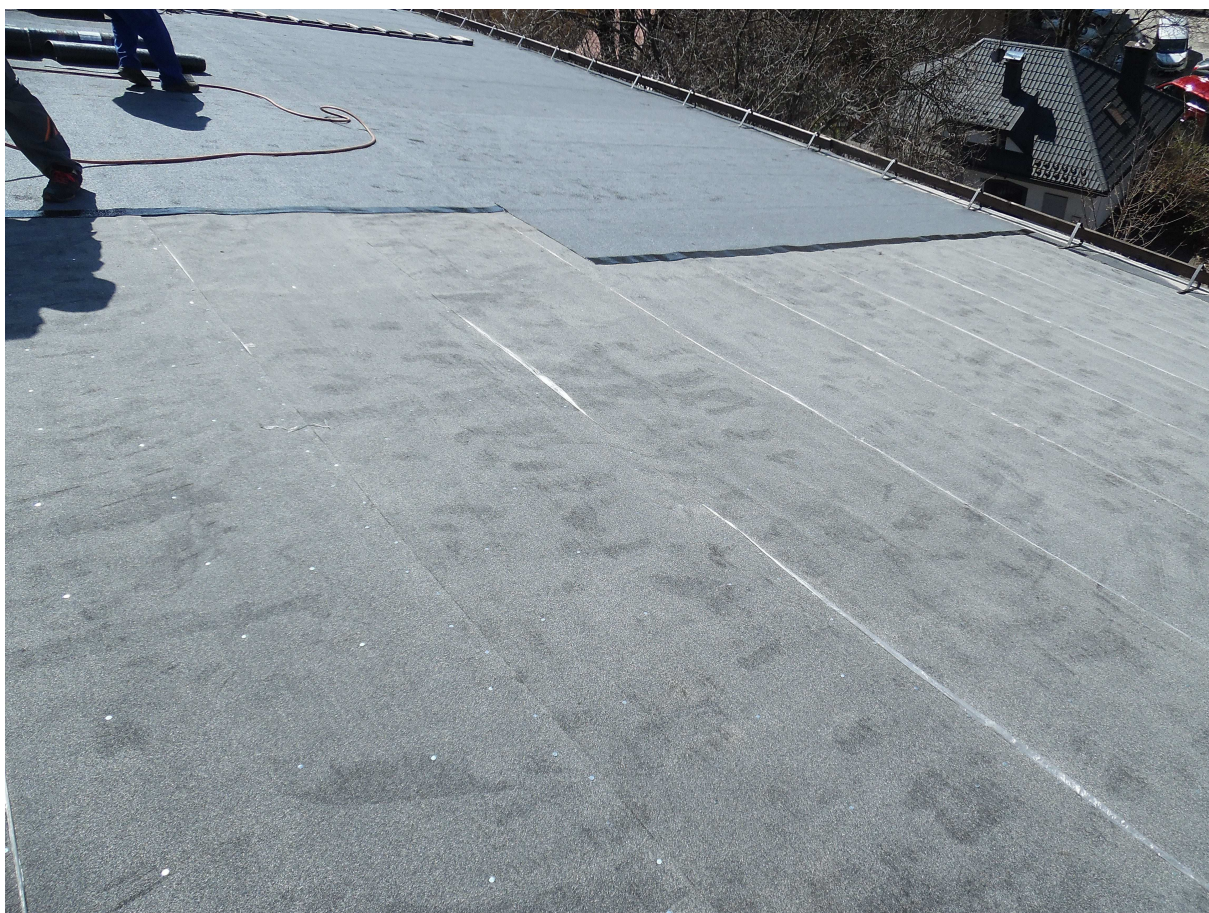
Śrutarska 39 – wykonanie pokrycia dachowego z papy termozgrzewalnej.
