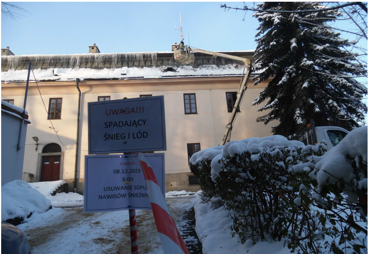
Usuwanie z dachów nawisów śnieżnych i lodowych – ul.Kochanowskiego (UM Cieszyn)
