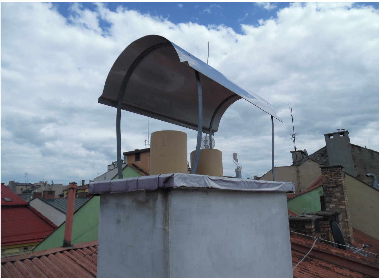
Wykonanie i montaż nasady kominowej – ul. Głęboka 31
