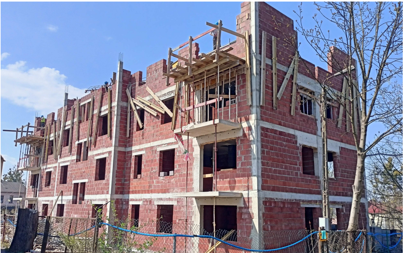
Budowa budynku wielorodzinnego przy ul. Mickiewicza II-III kw 2023 roku
