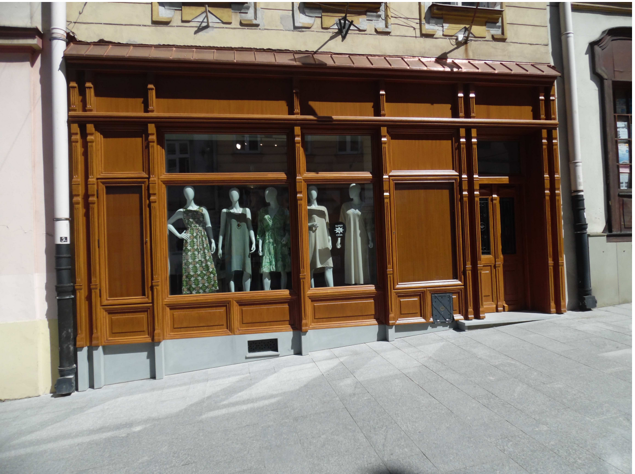
Wykonanie wraz z montażem witryny w budynku – u. Głęboka 58.
