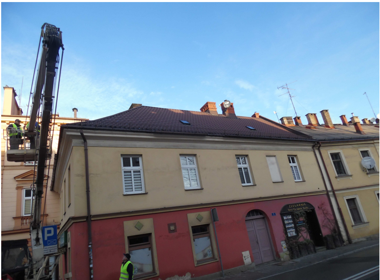
Roboty dekarские: 1. wykonanie zadaszenia ul. Katowicka 71, 2. wymiana rynny Garncarska 1.
