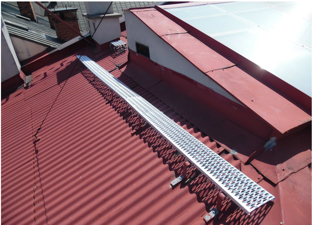
Prace dekarские – wymiana płotków śniegowych i ław kominiarskich – ul.Srebrna 1
