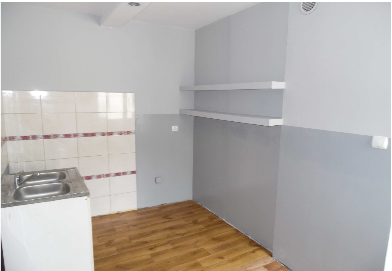
Prace malarskie na pustostanach – u. Towarowa 8/20
