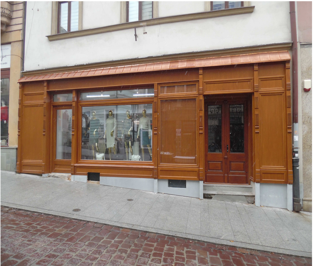
Wykonanie wraz z montażem witryny w budynku – u. Głęboka 53.
