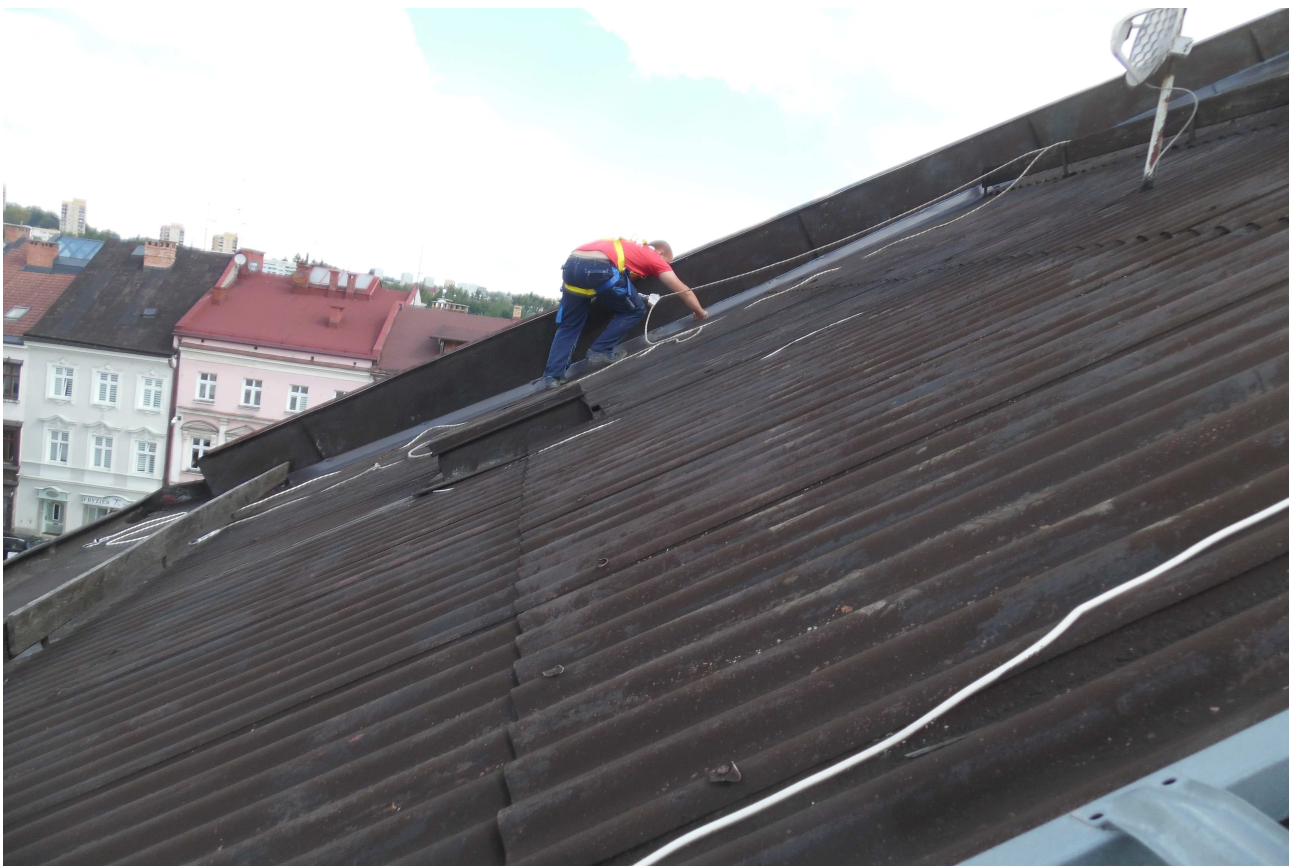
Prace dęcarskie: 1. krycie dachu papą ul. Przykopa 13, 2. wymiana obróbki blacharskiej - Stary Targ 11
