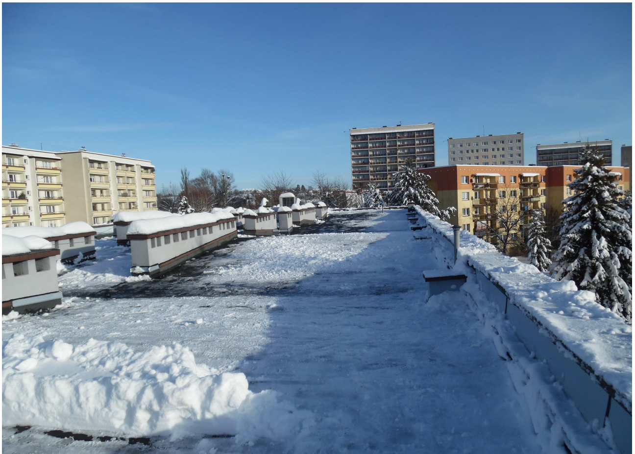
Usuwanie śniegu z dachu, budynek MOPS/Przedszkole na ul. Skrajnej.
