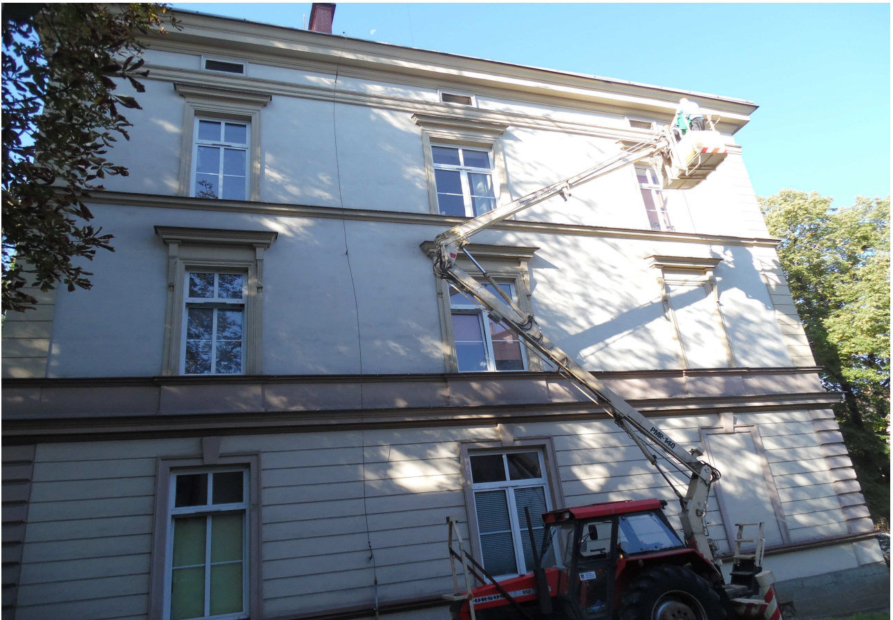
Montaż zabezpieczeń na elementach elewacji zabezpieczających przed siadaniem ptaków Pl.Poniatowskiego 9.
