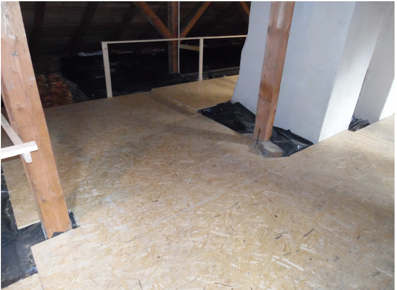
Docieplenie stropu poddasza - ul. Garncarska 1
