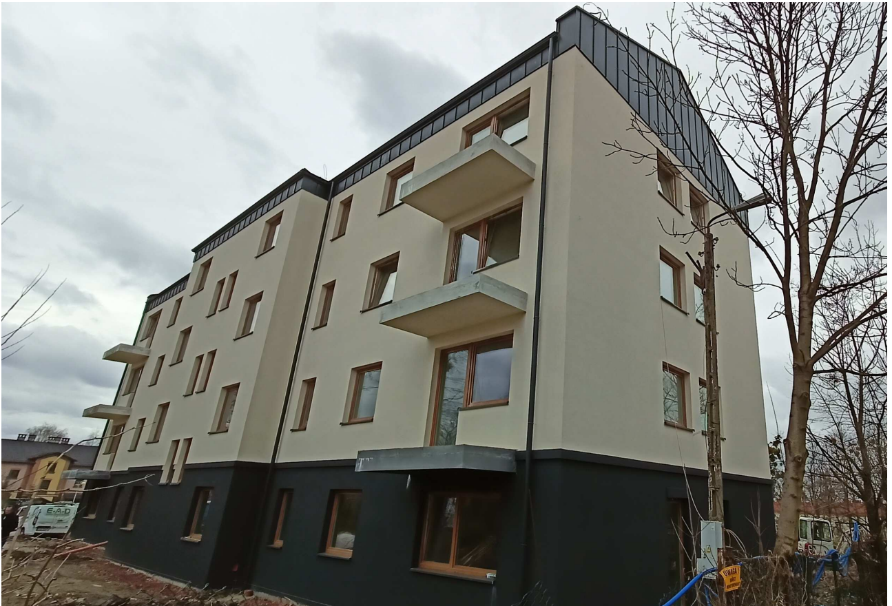
Budowa budynku wielorodzinnego przy ul. Mickiewicza koniec 2023 roku/początek 2024 roku
